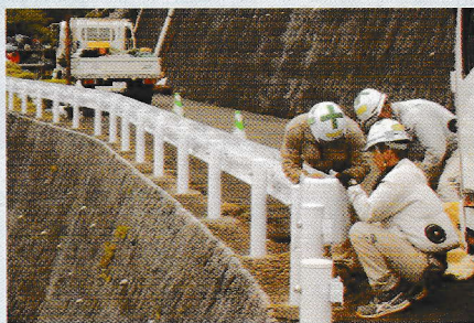
ガードレール設置工事
